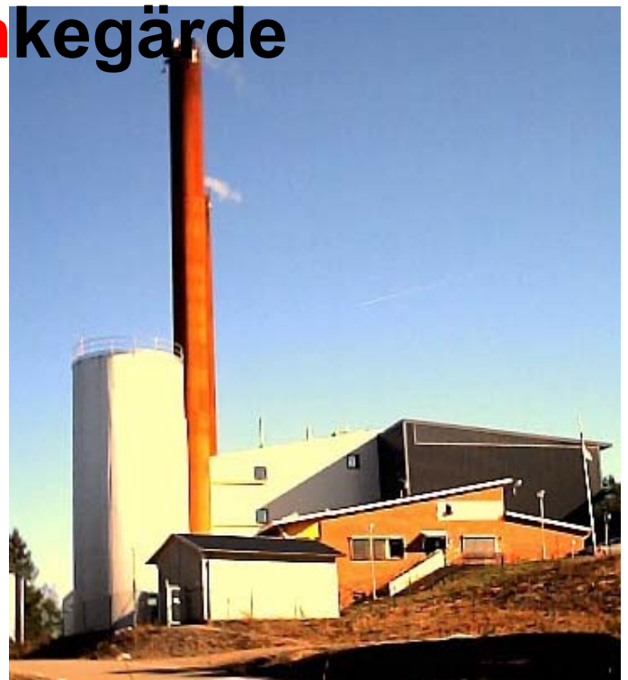
Munkegärdeverket, snart med miljöanpassad elproduktion.
